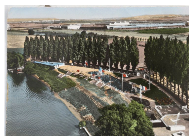
Vue générale de la plage. Photographie, vers 1950. (Collection particulière). Phot. Laurent Kruszyk IVR11_20147800351NUC4A
